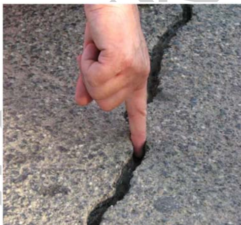
2. ábra. Kitisztított repedés és kiöntése fugamasszával
