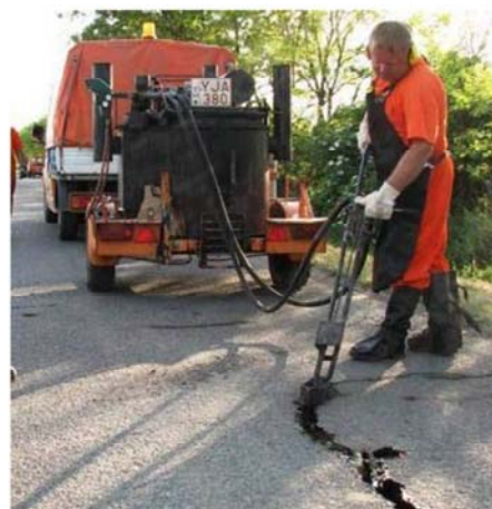
2. ábra. Kitisztított repedés és kiöntése fugamasszával
