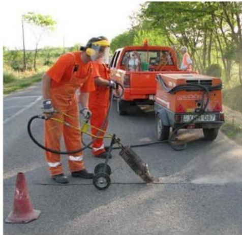
1. ábra. Repedés felbővítése gépi marással és kitisztítása
