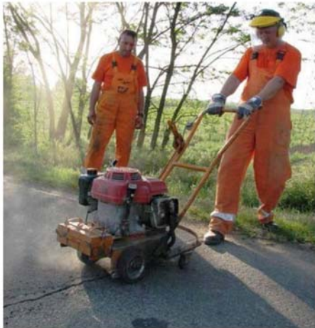
1. ábra. Repedés felbővítése gépi marással és kitisztítása
