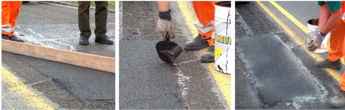
Csatlakozási szint ellenőrzés
