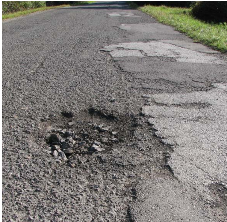
6. ábra. Hámlás következtében kialakuló nyitott felület és kátyú
