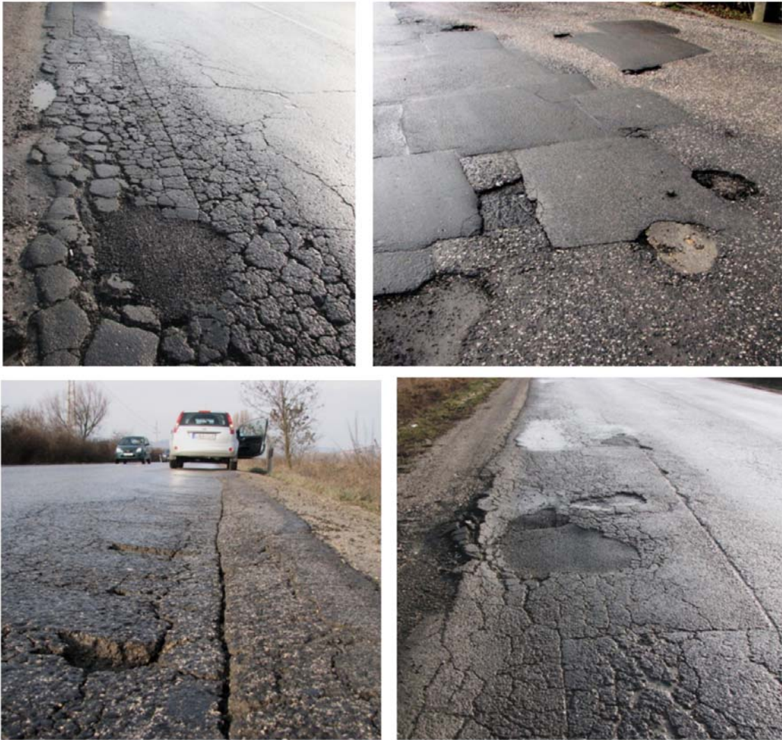
11. ábra. A szakszerűtlen javítás újabb burkolathibákat okozhat
