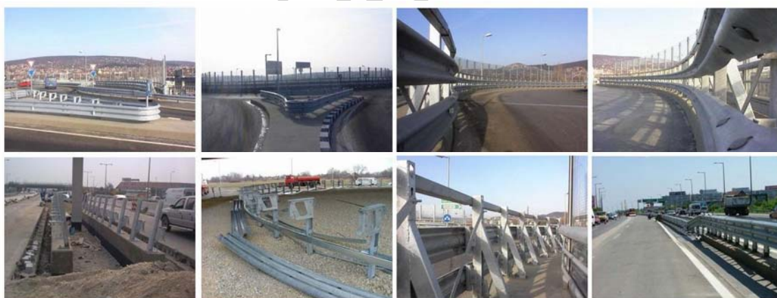
4. ábra. A vezetőkorlátok elhelyezése, kialakítása 4
