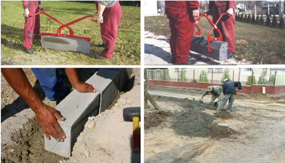
15. ábra. Szegélykövek emelése, beépítése
