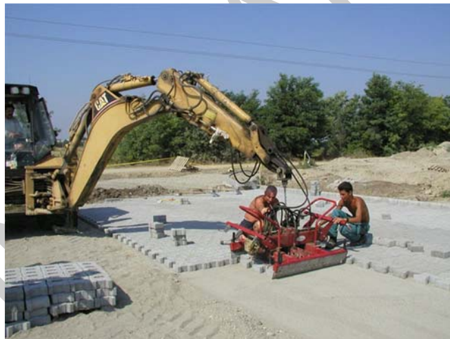
30. ábra. Betonkő burkoltok gépi fektetése 19
