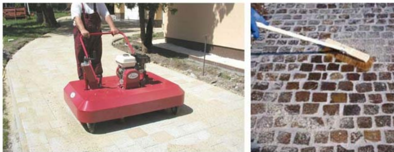
35. ábra. homok hézagokba söprése géppel és kézzel 22
