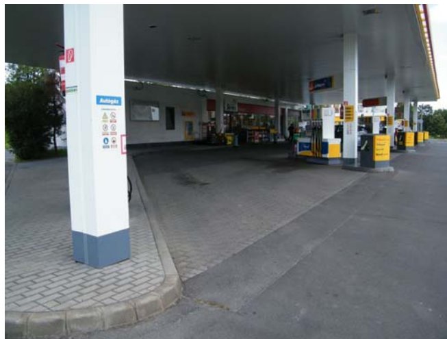
8. ábra. Benzinkútnál a töltőállomások betonkő burkolattal történő kialakítása
