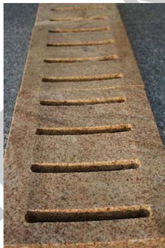
39. ábra. Burkolatba épített fedett folyóka 25
