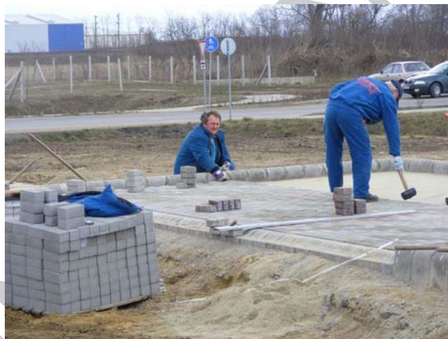
28. ábra. Kőburkolatok kézi fektetése 17
