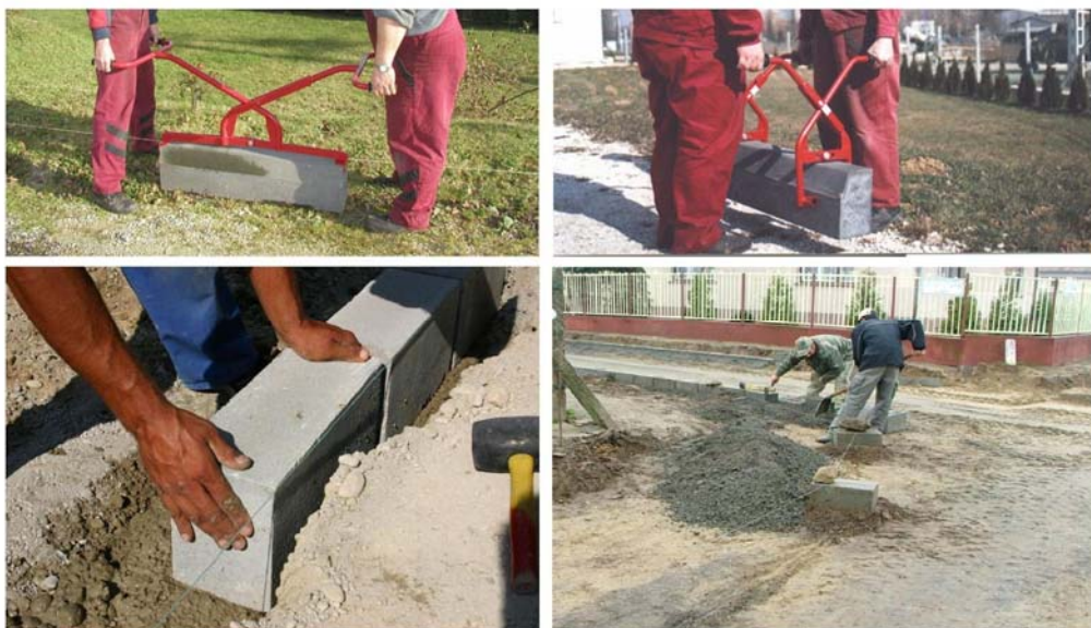
26. ábra. Szegélykövek emelése, beépítése
