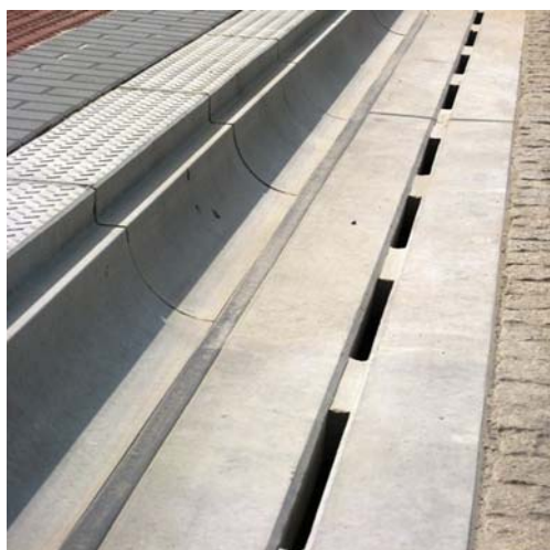
33. ábra. Fedett vízvezető elem 20
