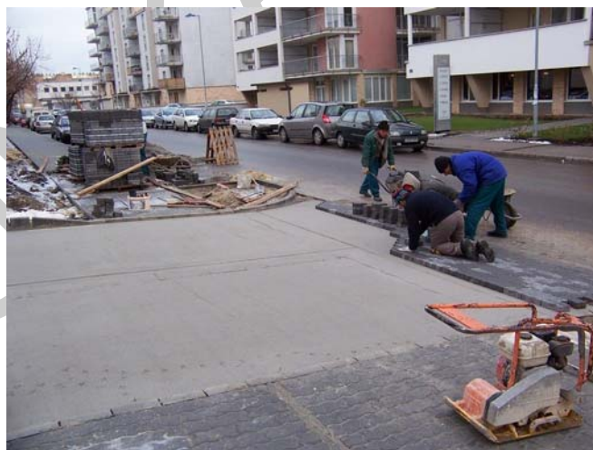
34. ábra. Tömörítés lapvibrátorral 21
