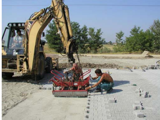
29. ábra. Betonkő burkoltok gépi fektetése 18
