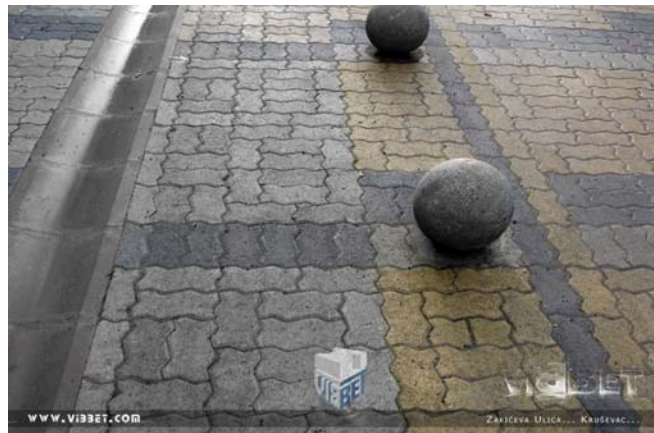
38. ábra. Burkolatba épített betonfolyóka 24
