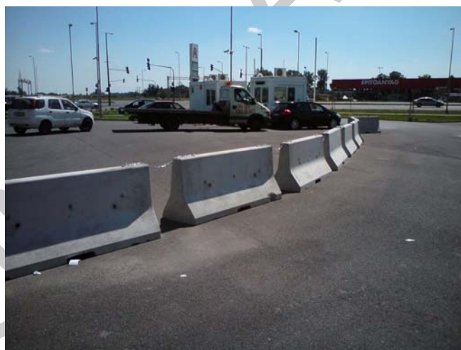
45. ábra. Forgalmterelés New Jersey betonelemekkel
