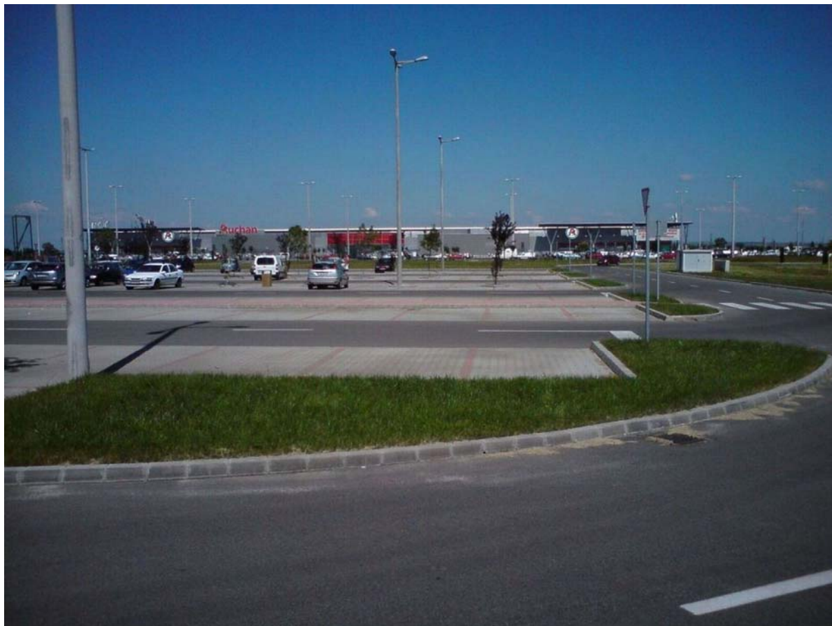
31. ábra. Elkészült, forgalomba helyezett betonkő burkolat
