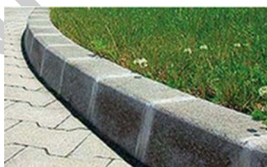
27. ábra. Szegélykő és burkolat kialakítása
