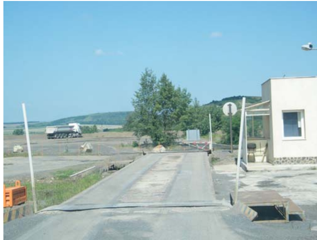
16. ábra. Tállya andezitbánya, késztermék kiszállításakor a szállító jármű súlyának mérlegelése az útpályába beépített hídmérleggel
