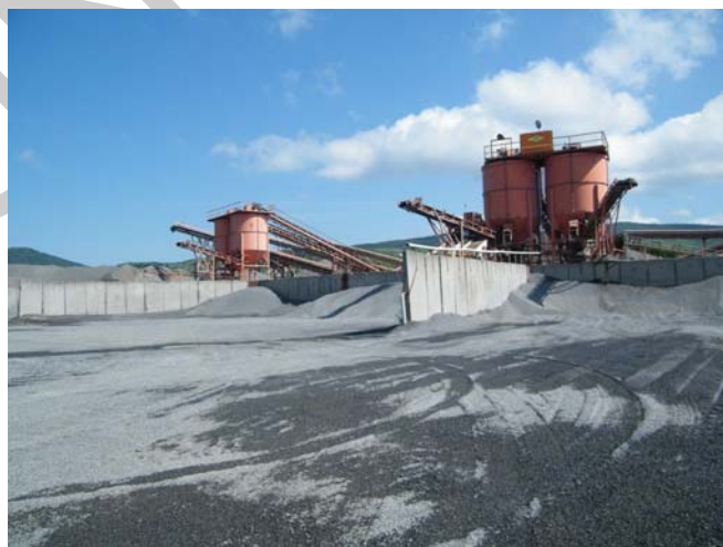
11. ábra. Tállya andezitbánya, a gyártás utolsó fázisa, a késztermékek ideiglenes elhelyezése frakciónként
