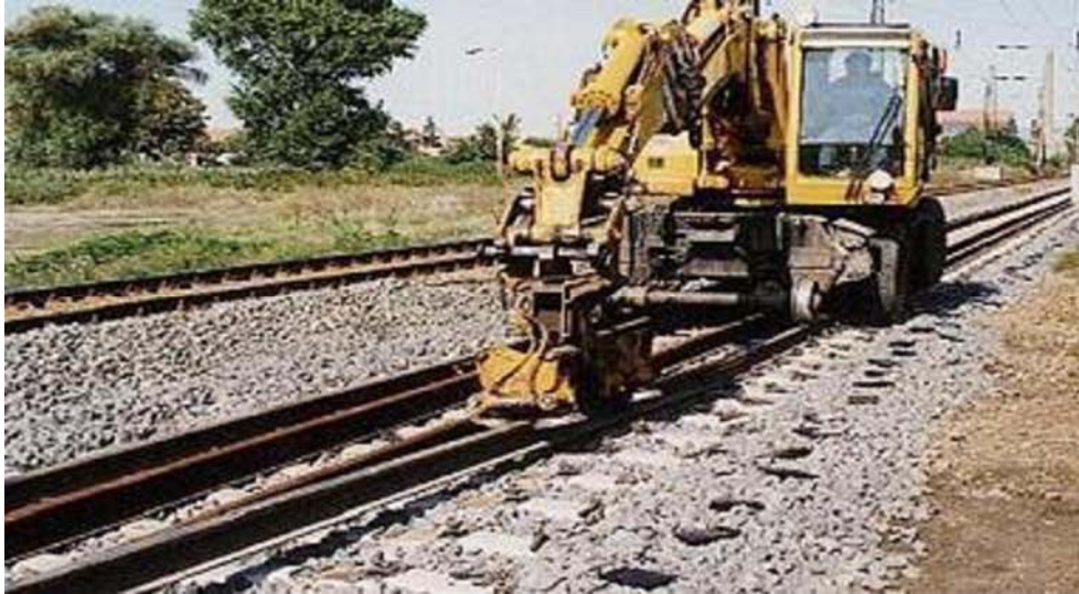
2. kép Síngombolás kotrógéppel2
