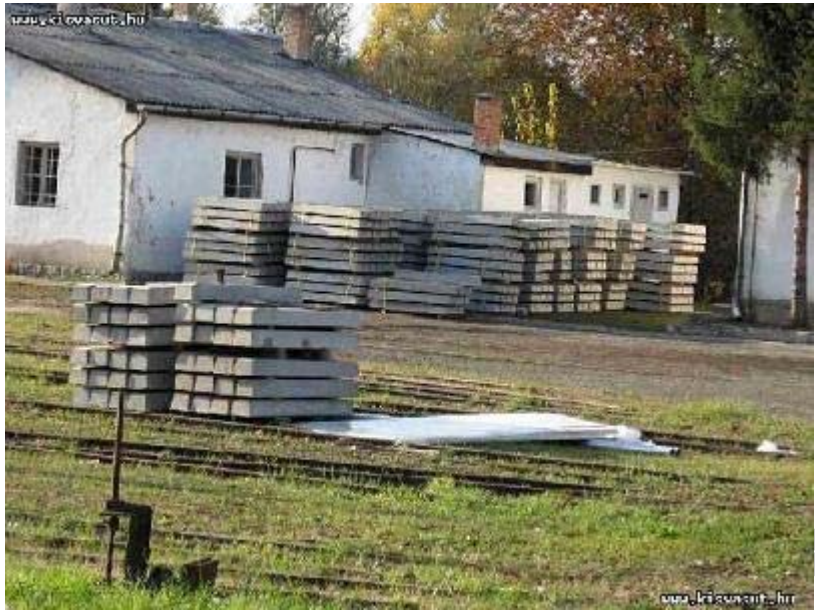
6. kép Vasbeton aljak elhelyezése beépítés előtt
