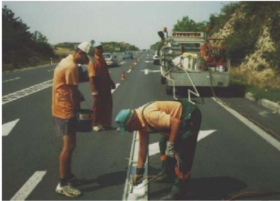
24. kép Útburkolati jelek festése
