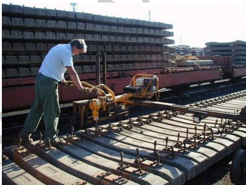
18. kép Vasbeton aljak elhelyezése szállítószerelvényen
