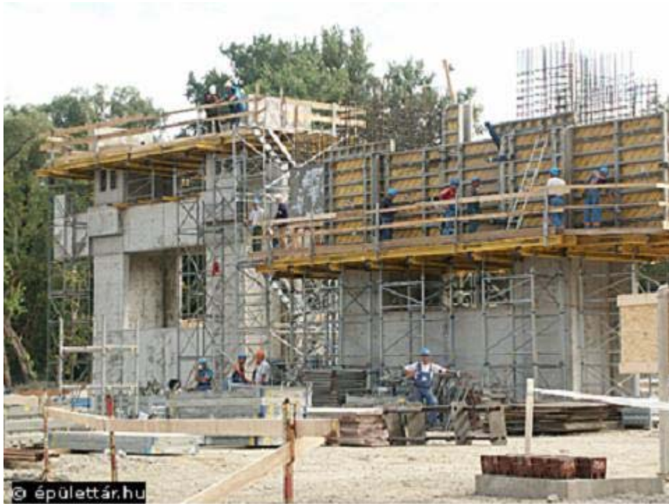
4. kép MO – ás híd pilléreinek építése, építési terület
