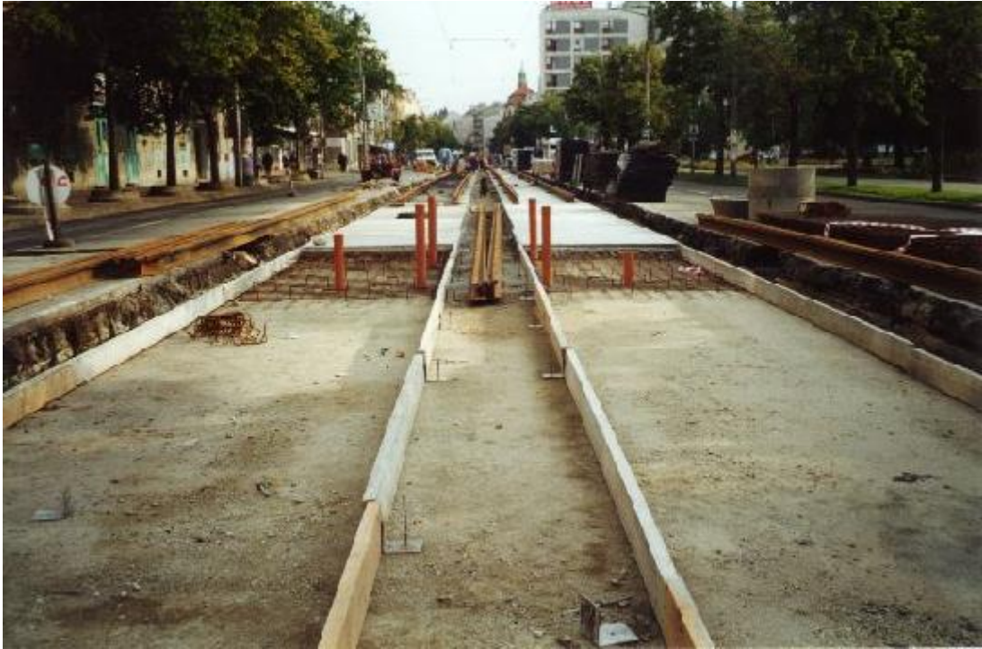
2. kép ORTEC-Isolast rendszerű vágány építése
