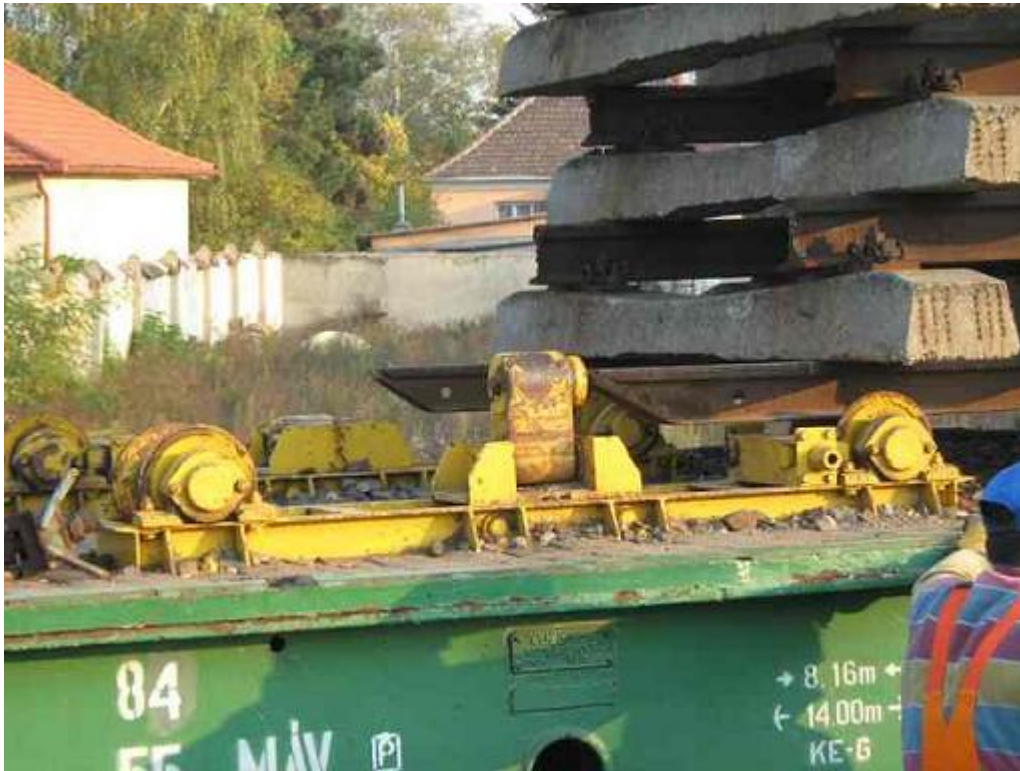
3. kép Bontott vágánymezők szállítása
