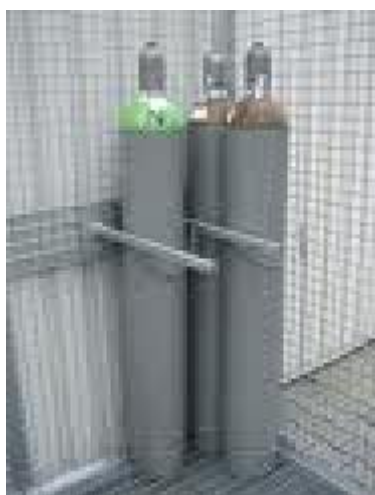
38. kép Gázpalack tároló
