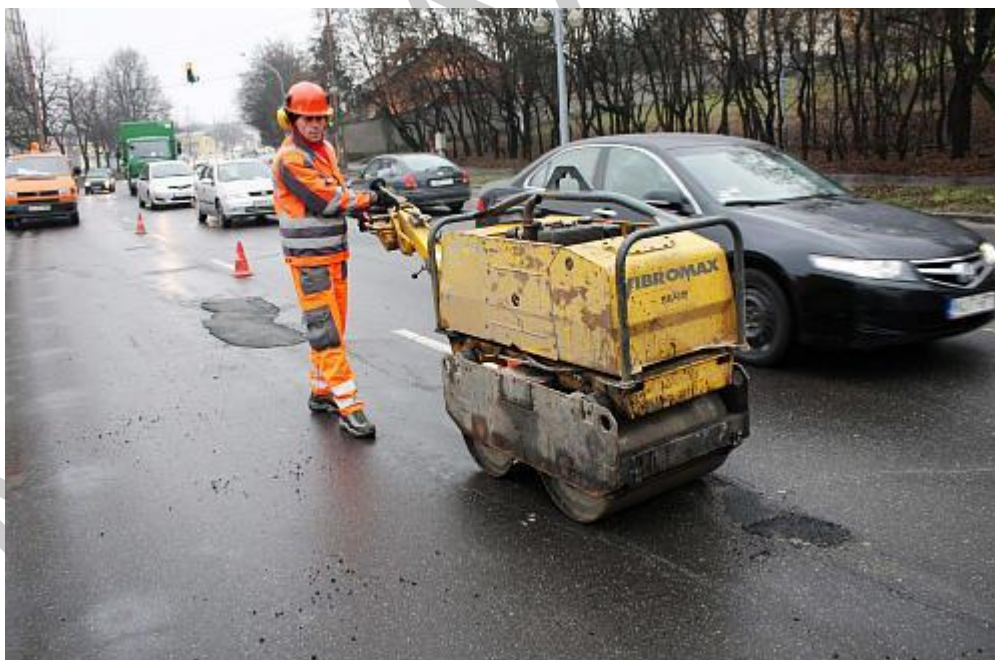
1. kép Burkolatjavítás
