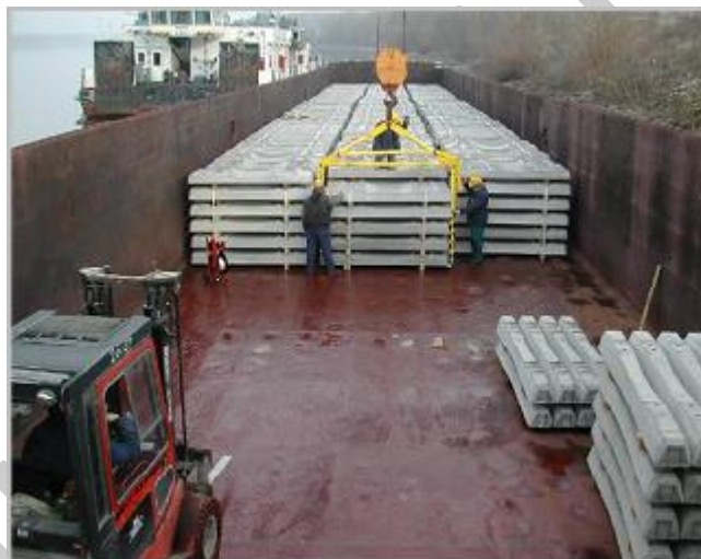
7. kép Vasbeton aljak szállítása, rakodása
