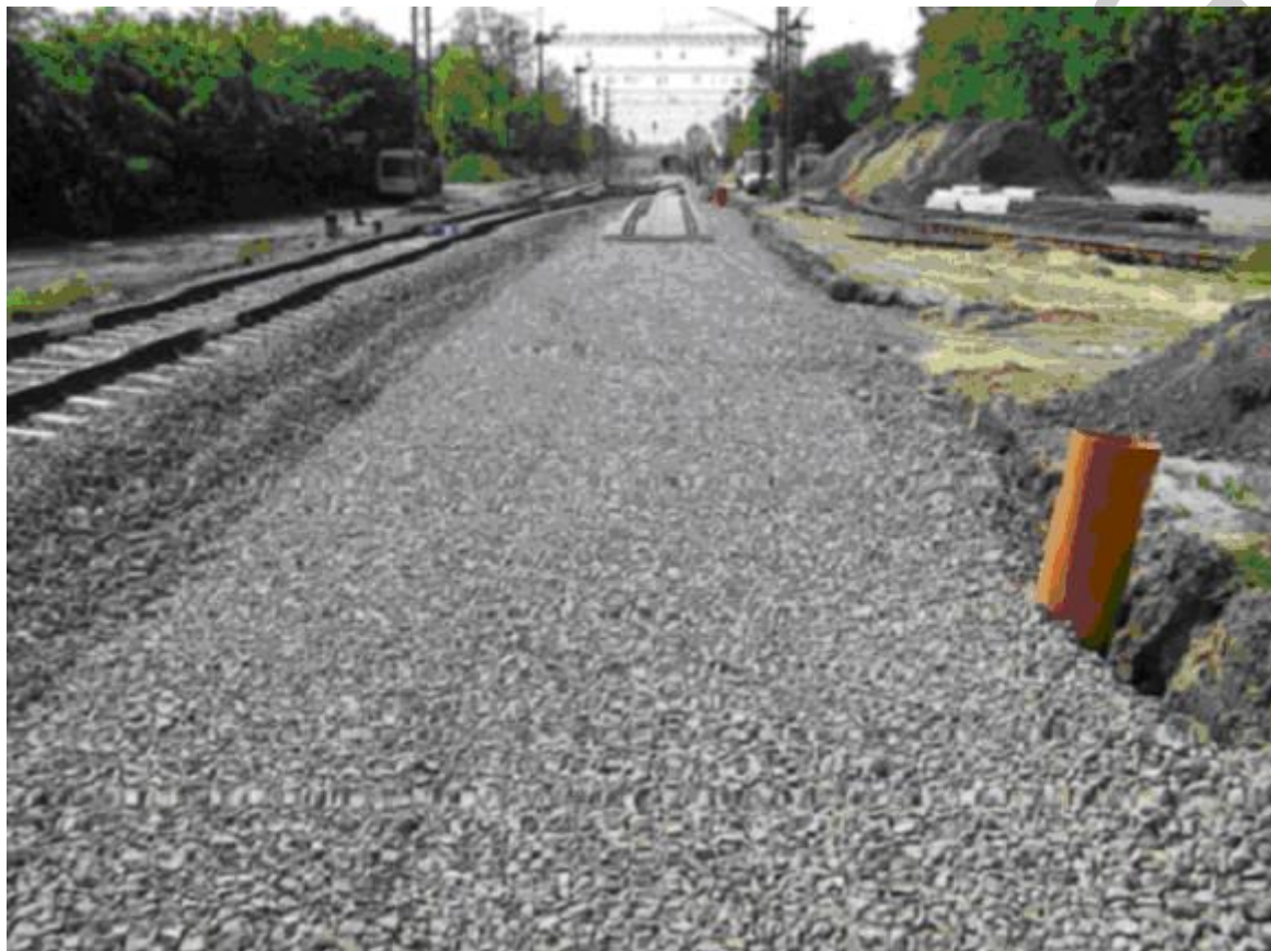
3. kép Vasúti vágány, kitérőszerkezet
