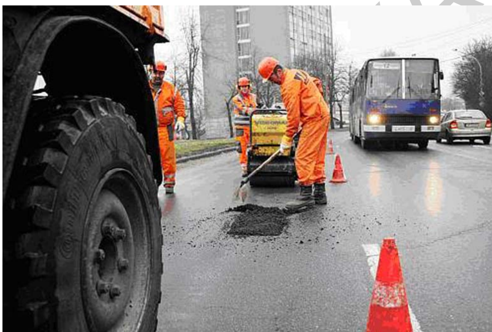
1. Kép Útburkolat javítása 1
