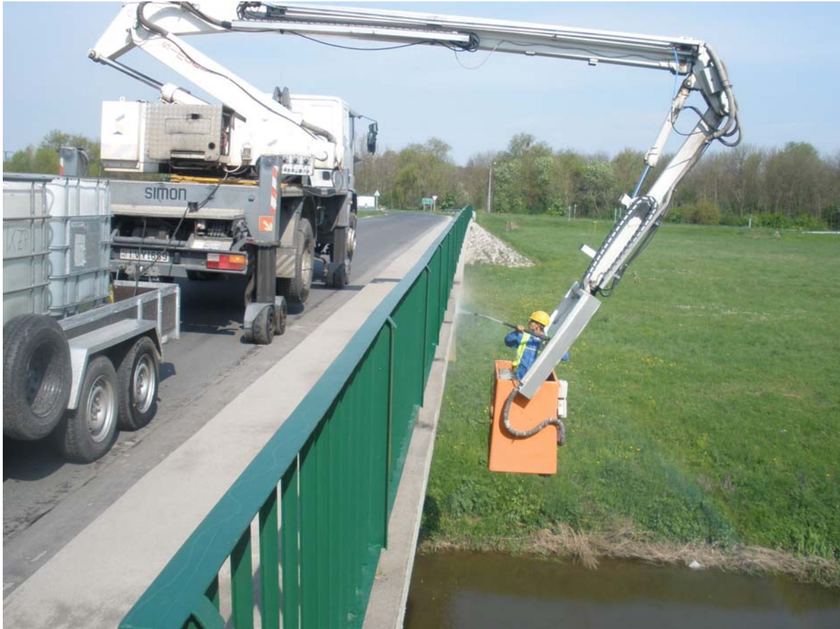
3. ábra. Tisztítás kosaras gépkocsiról
