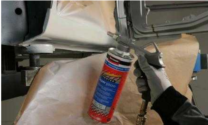
15. ábra. Javítás utáni kőfelverődés elleni védelem készítése
