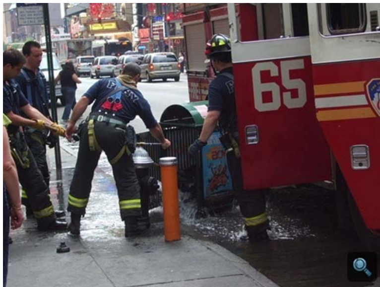
22. ábra. Tűzcsap szerelése 22
