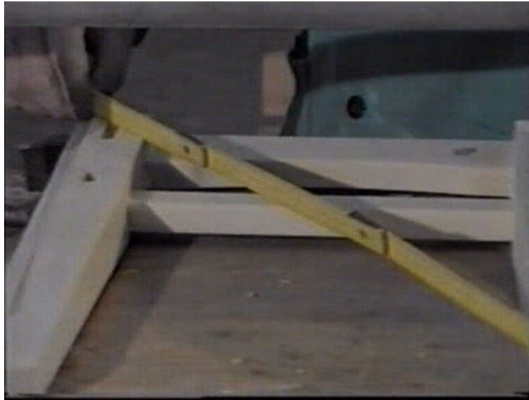
28. ábra. Átló mérése 28
