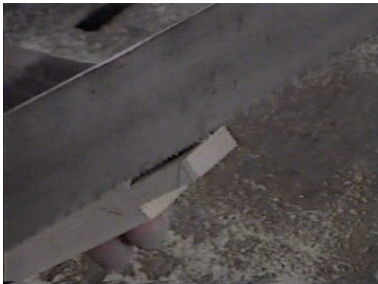
17. ábra. Csapvégek lefűrészelése 17
