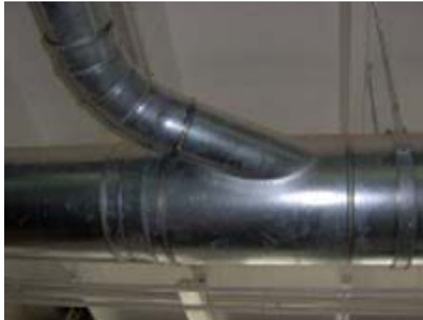
5. ábra. Csőcsatlakozó idom 5
