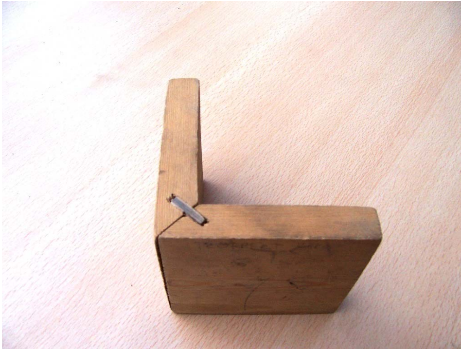
16. ábra. Kávakötés 45°-os sarok illesztéssel idegencsappal 16
