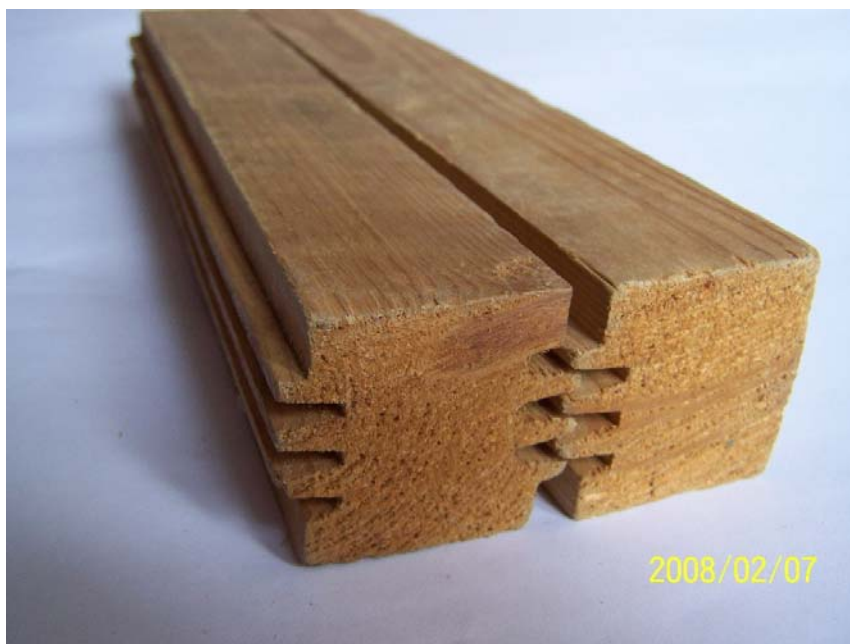
15. ábra. Ékcsapos szélesítő toldás 25
