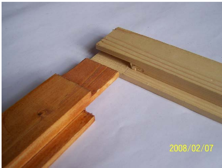
72. ábra. Ollós csapozás 2/3-ad aljazással82
