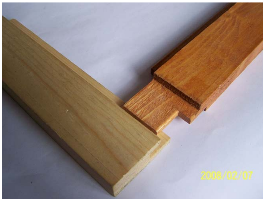
84. ábra. Fészkes szakállas vésett csapozás 2/3 -ad aljazással
